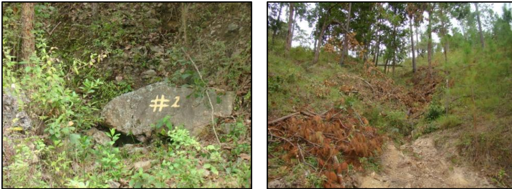
Figura No. 5 Sitio donde se colocaran las Alcantarillas
