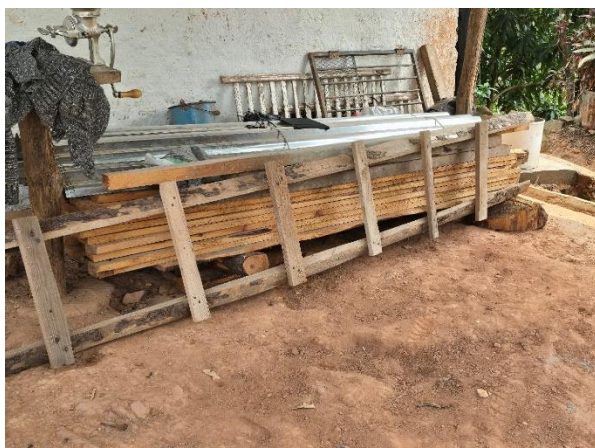
Figura 2 Parte de la madera aserrada para la reparación de la cocina en la Licencia No Comercial No. RFFM-LNC-029-2024. MFI, 2024. Valle de Ángeles, F.M.
